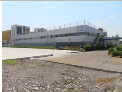
图 4：事故发生 215 生物池
