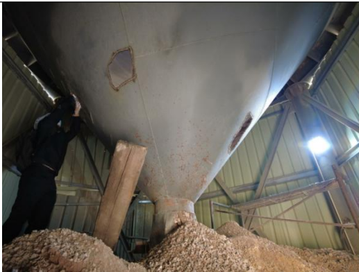
图六：筒仓底部下料口
